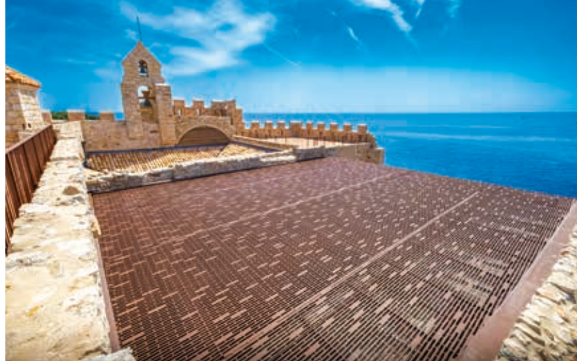
La création de deux toitures, dont une contemporaine, intégrée par l'architecte des Monuments historiques, a mis l'édifice hors d'eau, le protégeant durablement des intempéries.
