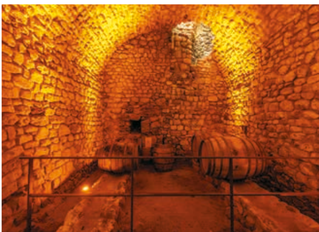
Un éclairage spécifique intérieur a été étudié pour mettre en valeur les différents espaces du monument.
