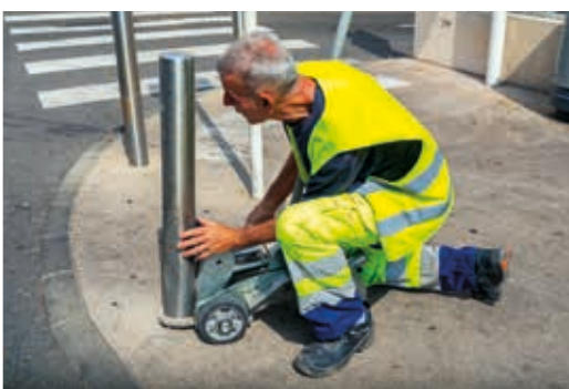
La régie voirie-signalisation est intervenue pour remettre en état le mobilier urbain dégradé.
