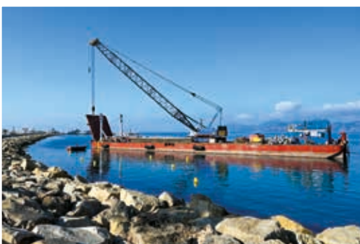
Située en face du chantier, une barge a permis de construire le puits de sortie du microtunnelier.
