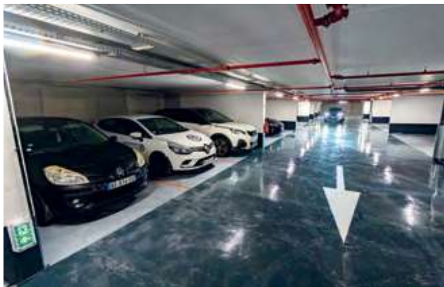
Un grand parking en ouvrage spacieux, moderne et sécurisé.
