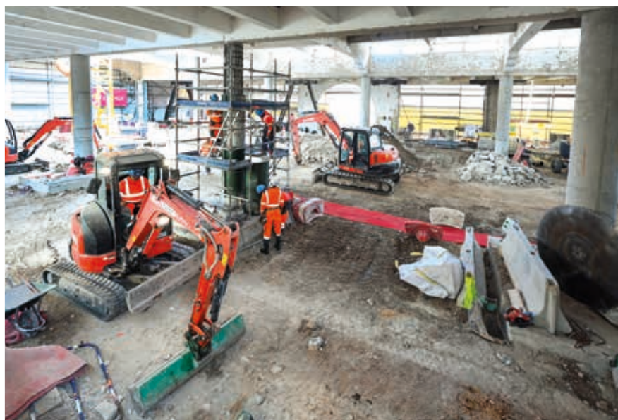
Les ouvriers ont dû élargir chaque poteau, comme ici, et refaire chacun de leurs massifs de soutènement en les adaptant aux nouvelles contraintes, tandis que des structures d'étalement ont dû être installées et ancrées pour soutenir le toit pendant les travaux.
