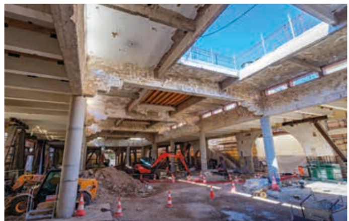
Les travaux sur le toit ont mis à jour des ouvertures préexistantes. Les plus petites, en longueur, fragilisent l'ensemble et devront être comblées tandis que les plus larges seront exploitées pour créer des puits de lumières.
