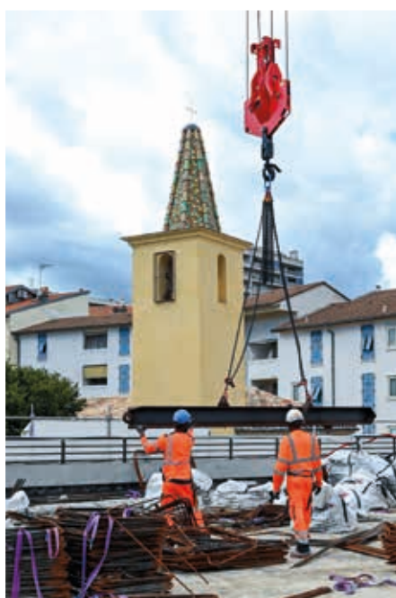
Les matériaux sont acheminés et évacués via le toit pour limiter les désagréments.
