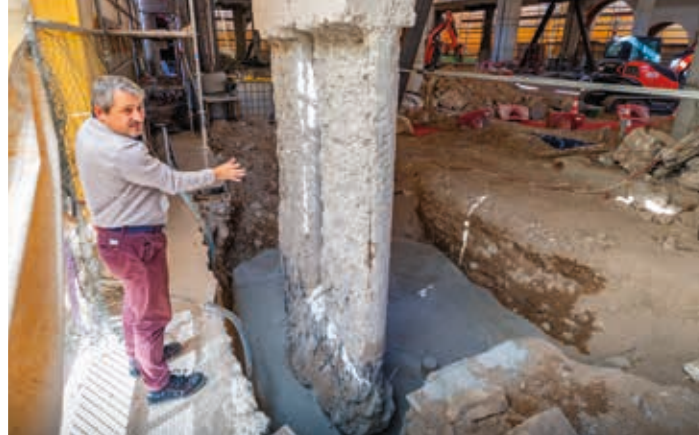
L'architecte Stéphane Becker, directeur des projets urbains de la Mairie de Cannes, montre les piliers qui ont dû être partiellement démolis pour pouvoir être renforcés tout en restant alignés avec la façade.
