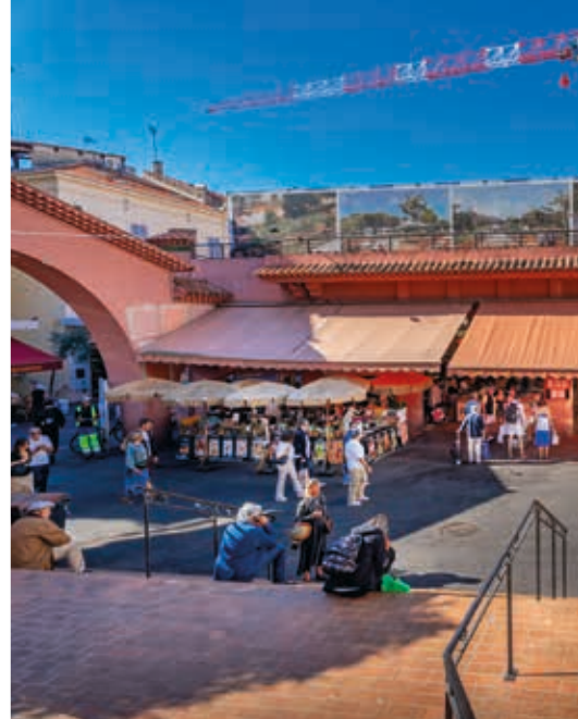
Le chantier a été conçu pour que l'activité des maraîchers puisse continuer en parallèle sur le site.
