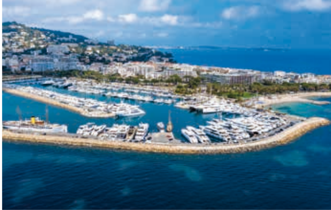
Le site portuaire est protégé par deux digues qui seront prochainement renforcées.
