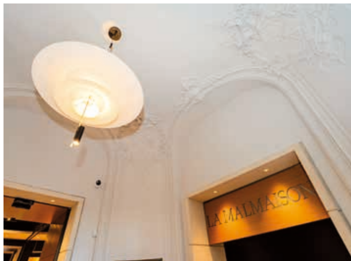
Les moulures de l'édifice ont été préservées et mises en valeur. L'utilisation de bois de chêne et de pierre de Chassagne Beauharnais a conféré à l'ensemble de la réhabilitation chaleur et élégance.
