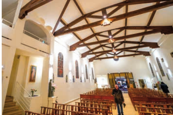
Sous sa toiture entièrement restaurée, l'église peut accueillir jusqu'à 350 fidèles en même temps, entouré d'un chemin de croix en céramique signé Odette Lecat-Delfino.
