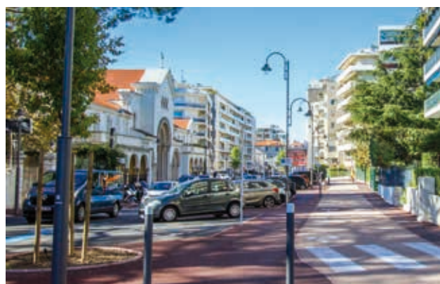
Les cheminements piétons ont été sécurisés avec la rénovation des trottoirs en enrobé rouge, leur mise en accessibilité et la création de traversées piétonnes clairement identifiées et sécurisées.
