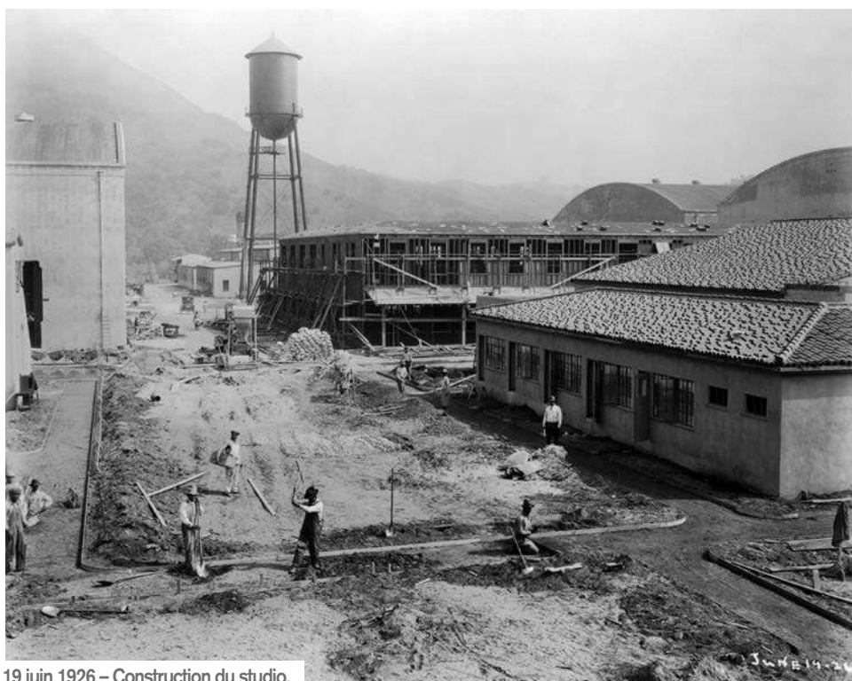
19 juin 1926 – Construction du studio.
