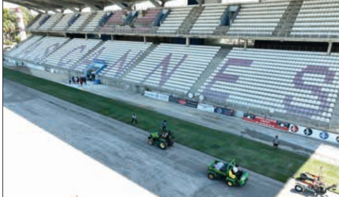
Le 22 août dernier, la nouvelle pelouse naturelle renforcée financée par la Mairie de Cannes était en train d'être installée au stade Pierre de Coubertin.
