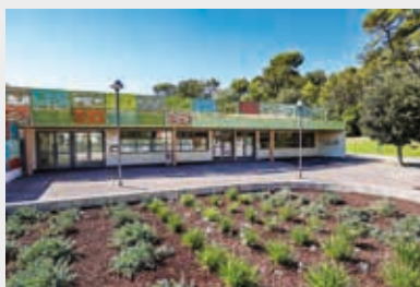
La façade de l'école maternelle Marcel Pagnol a été repeinte.
