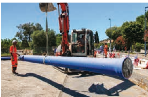
Le Programme eau prévoit de continuer à renouveler les équipements existants (ici le réseau d'eau potable du Sicasil) pour réduire les fuites éventuelles.
