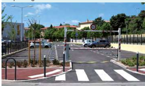
Le parking du Caroubier
