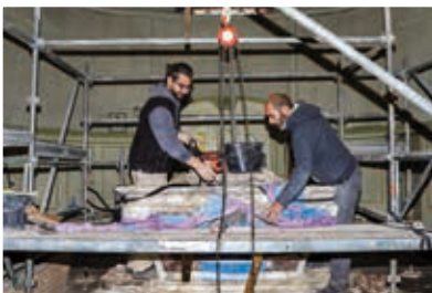
Très endommagé, le maître-autel a été complètement démonté ; son massif, situé à l'intérieur, a été démolé afin d'en construire un nouveau.
