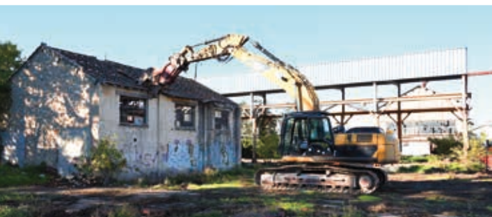
Le 10 novembre dernier, le premier coup de pelleuse a marqué le lancement des travaux de démolition des bâtiments désaffectés du site qui concernent une surface de près de 39 000 m 2 .
