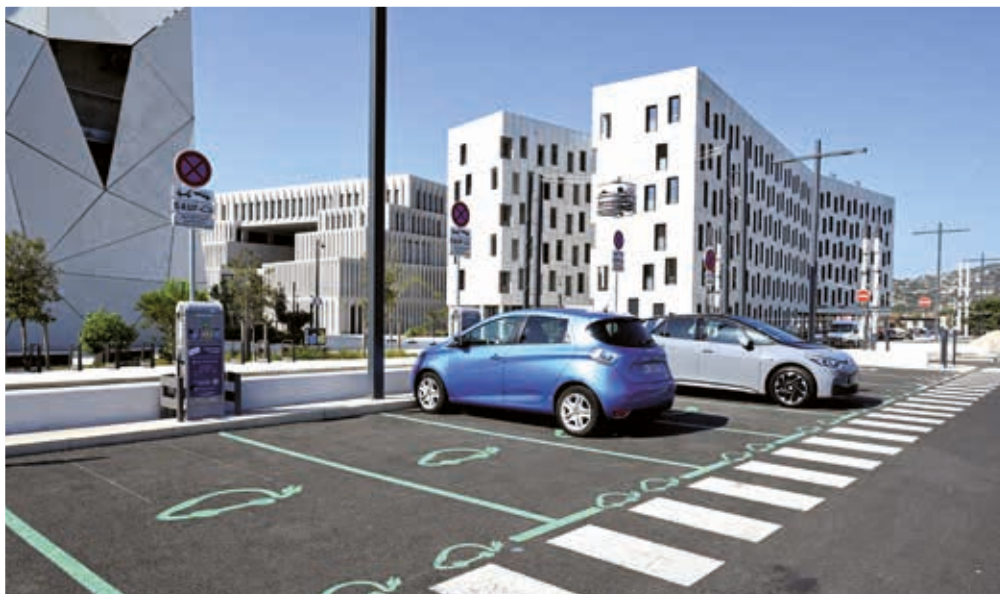
La résidence bénéficie aussi du vaste parking multimodal qui dessert le site de Bastide Rouge : aujourd'hui 334 places gratuites de stationnement, et à terme 1000 places.
