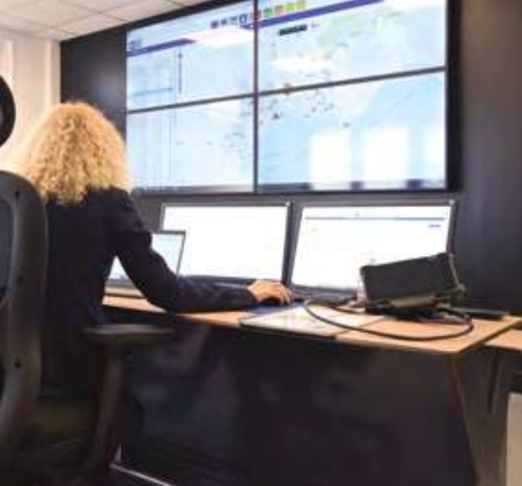
Le Système d'Aide à l'Exploitation (SAE) mis en place au Centre de collecte des déchets de l'Agglomération Cannes Lérins est un outil de dernière génération.
