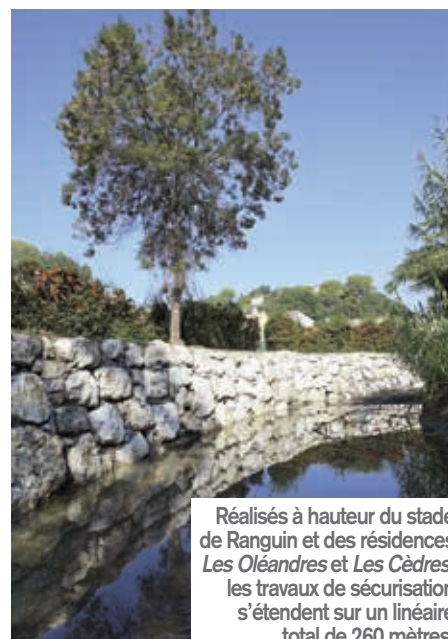
L'Agglomération Cannes Lérins a engagé, en juillet dernier, un chantier de restauration des berges du vallon de la Frayère affaiblies par les intempéries de novembre et décembre 2019 et présentant des risques d'effondrement.
