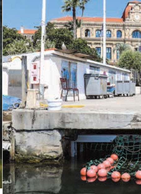
Des filets à macro et micro déchets ont été disposés à Cannes, comme ici sur les exutoires du Vieux-Port.
