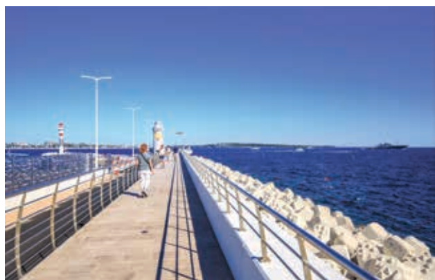
Tout au long de la jetée, côté mer, 4 224 acropodes ont été posés avec l'aide de plongeurs via un GPS et une grue de 70 mètres de haut. Ces blocs en béton armé de neuf tonnes chacun ont été fabriqués à La Bocca par le groupe SPADA.
