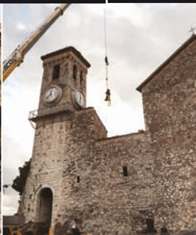
Le spectaculaire envol de l'une des cinq cloches : chacune a été soulevée à l'aide d'une grue autoportée combinée avec des palans à chaînes...
