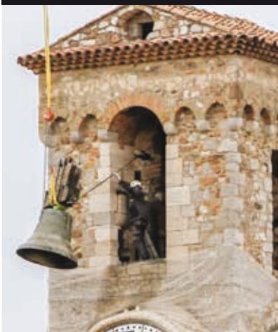
L'une des parties les plus délicates de l'opération : la sortie de la cloche. Aucun clocher n'étant identique, le campaniste s'était rendu sur site auparavant pour évaluer la situation cannoise.
