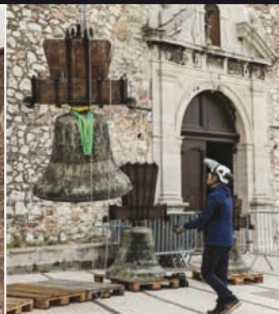
... jusqu'à un atterrissage en douceur, orchestré comme toute l'opération par Éric Baricault et ses équipes. Ensuite, les cloches ont rejoint un semi-remorque dans lequel elles ont pris la direction des ateliers du campaniste, situés à Cholet.
