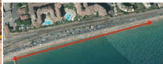
... tandis que les travaux de la phase 4, débutés en octobre dernier, seront localisés entre les passages Pierre Sémard et Verrerie jusqu'en juillet 2021.
