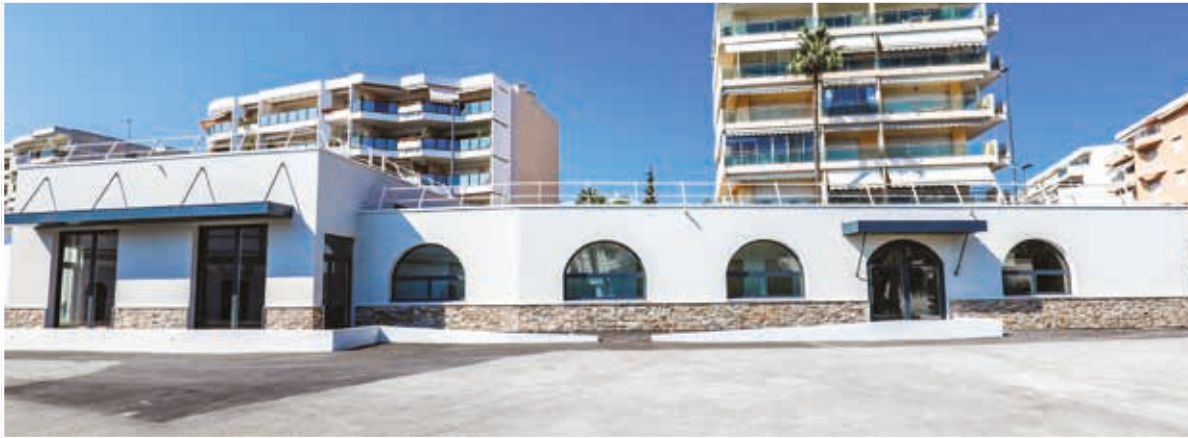
La nouvelle salle multi-activités à l'architecture soignée s'intègre parfaitement dans l'enceinte du mythique stade des Hespérides.
