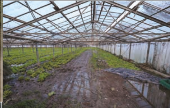
Les serres de Jean-Charles Orso ont été totalement inondées.
