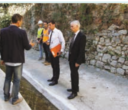
David Lisnard, sur le terrain pour contrôler les travaux de réaménagement et de réparation des vallons abîmés par les crues, auxquels l'Agglomération Cannes Lérins a consacré 4,4 M€ en 2018.
