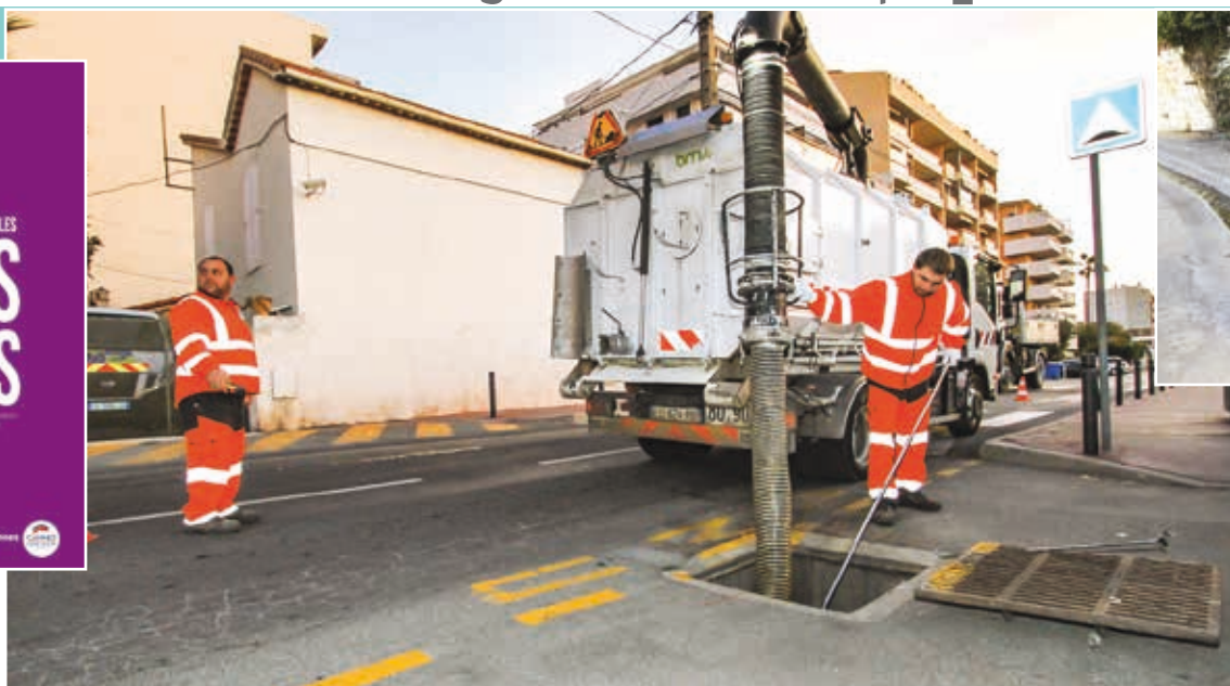
74 000 opérations de nettoyage des avaloirs sont réalisées chaque année pour faciliter l'écoulement des eaux pluviales.
