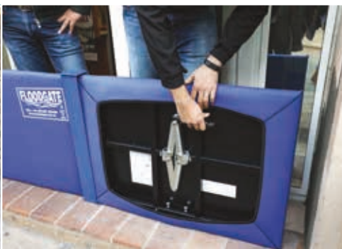
Les batardeaux, des dispositifs qui retiennent l'eau en cas d'inondation, sont conseillés aux habitants des zones à risque.
