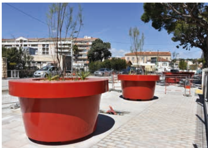
Un pavage de qualité et un matériel urbain modernisé sont installés dans les rues de Bocca centre.
