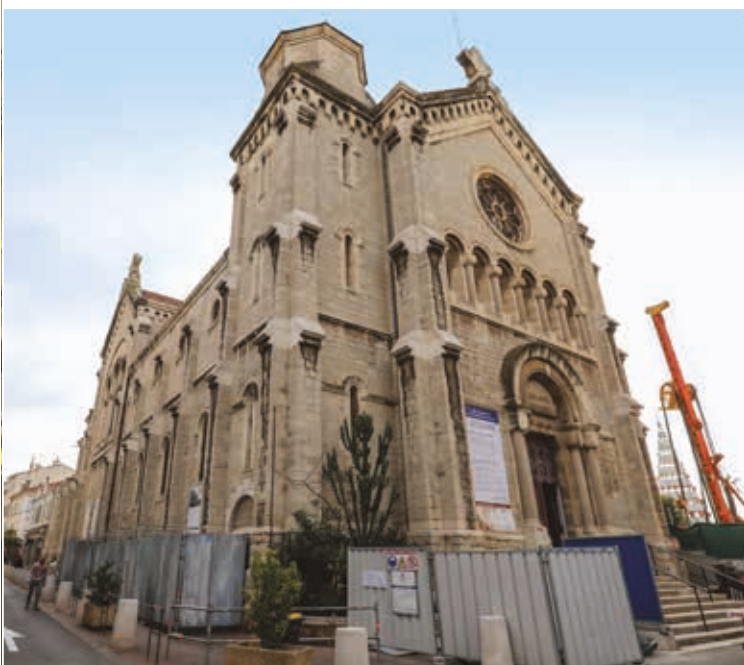
La deuxième phase des travaux de rénovation consacrée à l'extérieur du lieu de culte a débuté en janvier dernier pour s'achever avant mai 2019.
