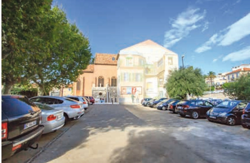
Le parking des Artistes, rue Saint-Dizier, a été réalisé dans le cadre de la vaste opération de piétonnisation du Suquet, désormais pavé et embelli.
