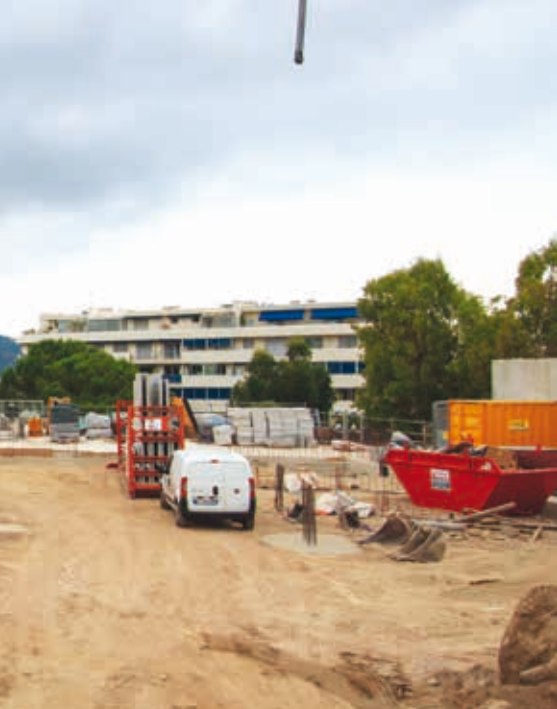
Ci-contre : Un chantier spectaculaire par son ampleur qui verra naître le nouvel établissement à la rentrée 2018.
