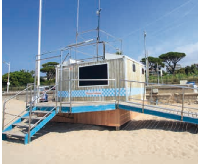
Les six postes de secours, ouverts 7 jours sur 7, ont reçu un nouvel habillage cet été pour mieux s'intégrer dans l'environnement du littoral.
