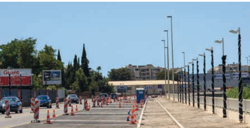
Le stationnement a été optimisé, comme ici grâce à la création de nouvelles places en épis le long du boulevard du Rivage desservi par la navette de la plage gratuite.
