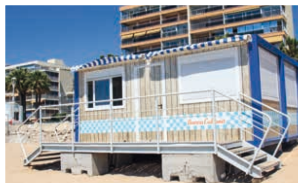
Le nouvel habillage des postes de secours cannois arbore les couleurs et le visuel de Boccababana.
