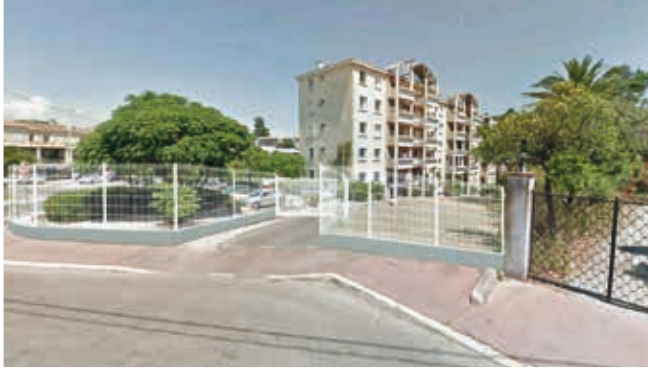
Des opérations de mise en sécurité sont réalisées sur douze résidences, comme ici aux Périer/Riou .
