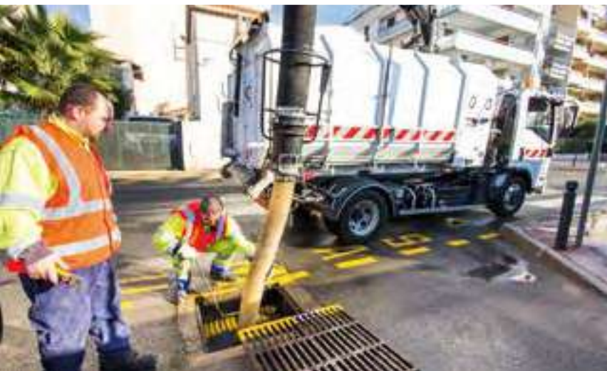
La nouvelle cureuse qui nettoie plus efficacement les avaloirs de Cannes, pour lutter contre les inondations.
