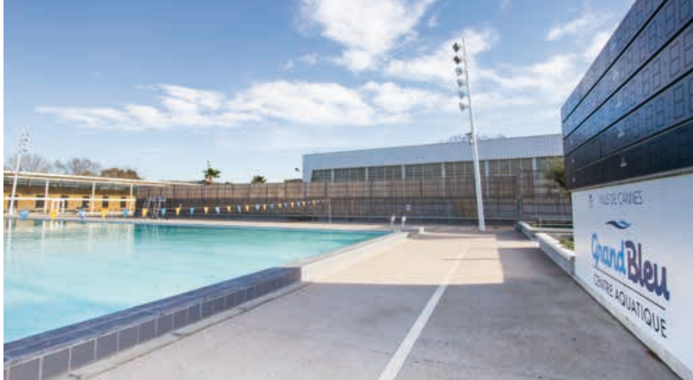
Le bassin de la piscine Grand Bleu est hors d'usage mais les services sont à pied d'œuvre afin de permettre sa réouverture pour la saison estivale.
