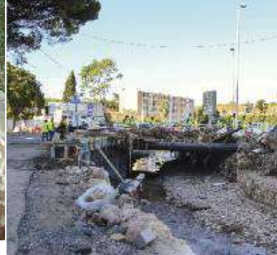
La Frayère à La Bocca, dont le débordement a causé des dégâts considérables.
