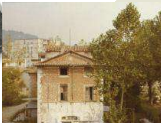
La ferme Giaume en 1974 avant les travaux de restauration
