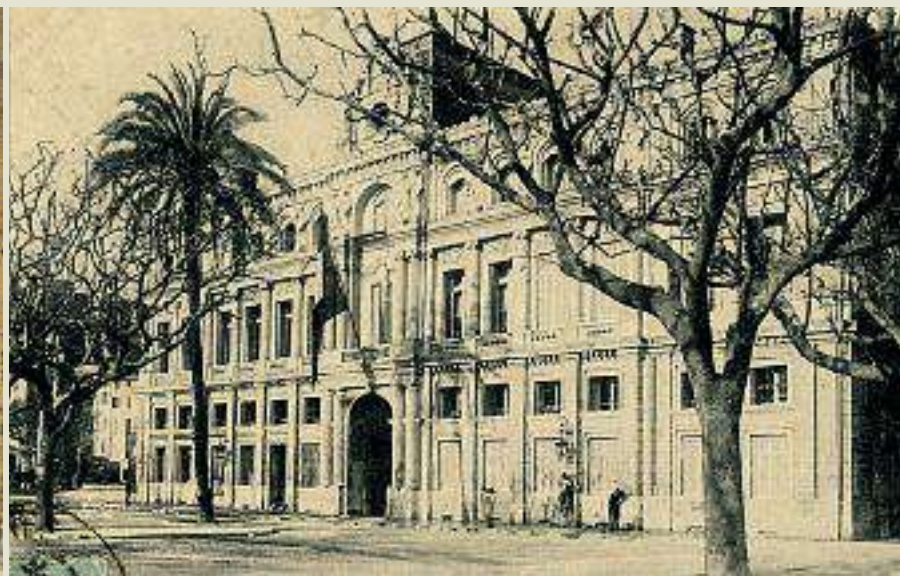
1900/1905 : vue du côté sud de l'hôtel de ville, des employés nettoient la façade.
