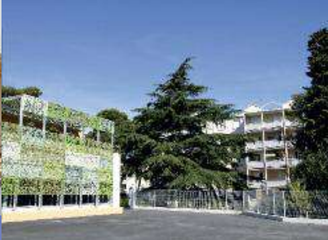
La cour de l'école élémentaire, à la fois sécurisée et largement ouverte sur le quartier.
