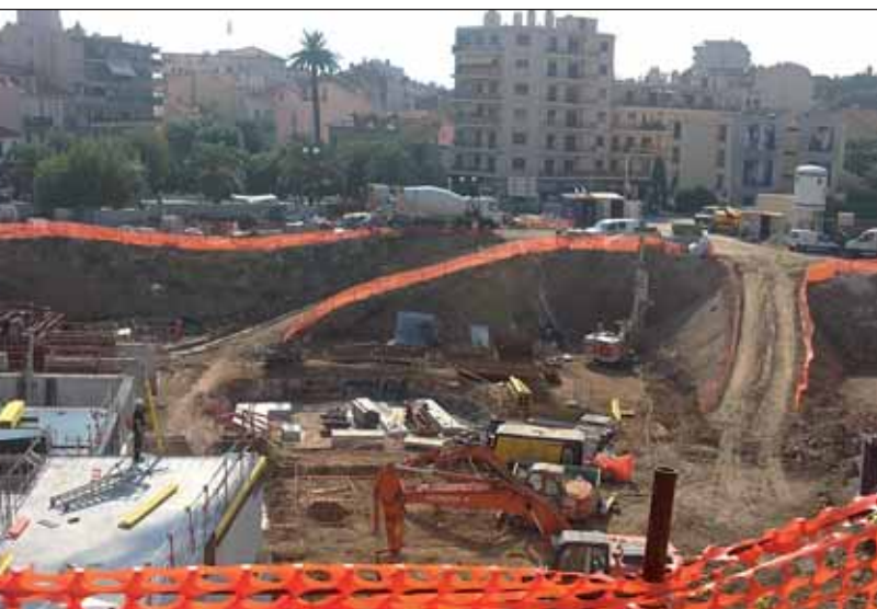
Le chantier de Cannes-Maria suit activement son cours.
