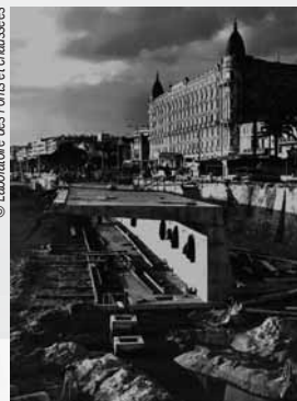
La Croisette pendant les travaux (1961-1963).
