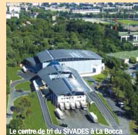
Le centre de tri du SIVADES à La Bocca
