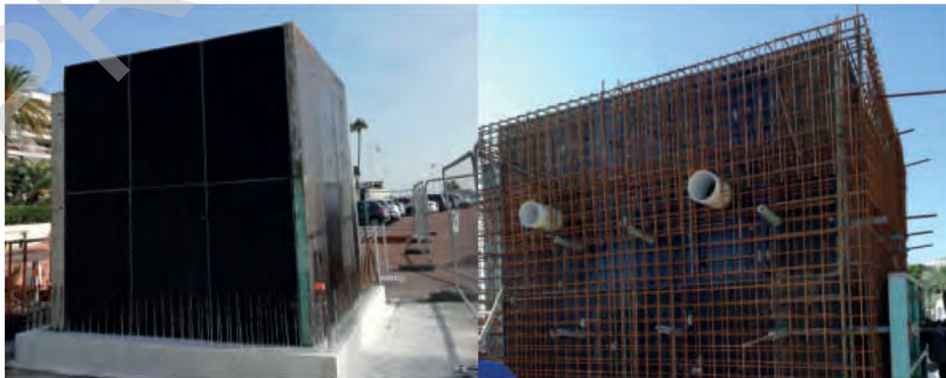
Travaux de la mise en place d'une cuve de désodorisation du poste de relevage réseau eaux usées parking Moure Rouge
