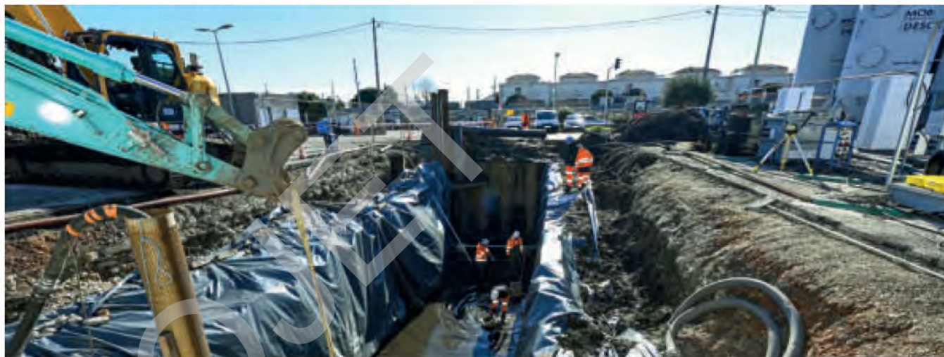
Travaux de la mise en place d'une cuve de désodorisation du poste de relevage réseau eaux usées parking Moure Rouge
