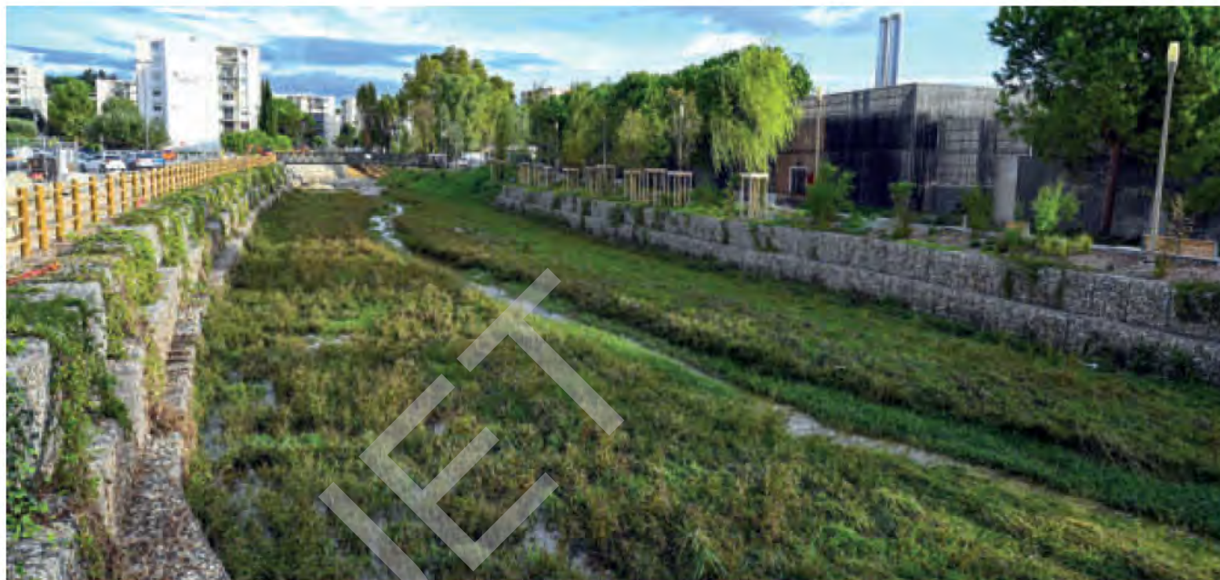
Travaux de recalibrage de la Frayère
