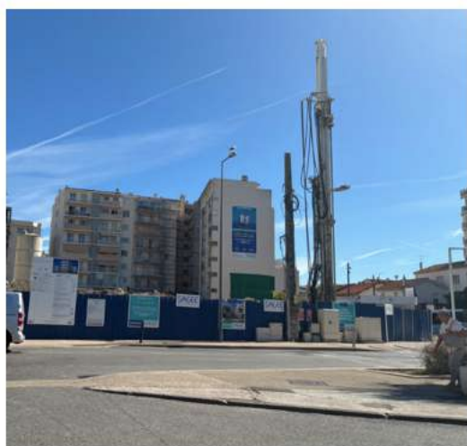
- Visite sur site 25/9/2025 -
