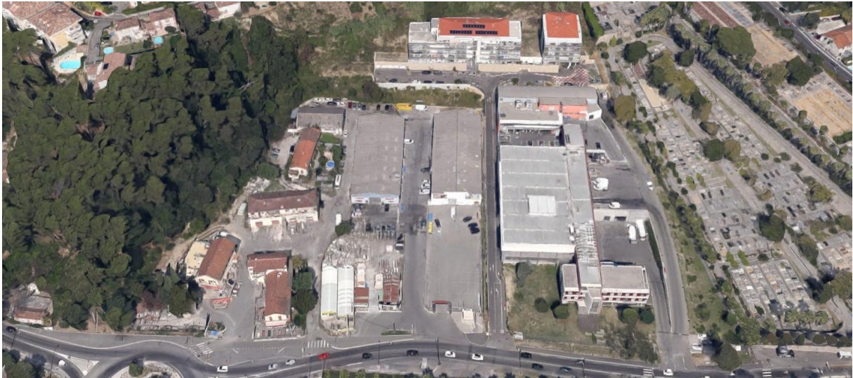
Photo aérienne du secteur Sud
