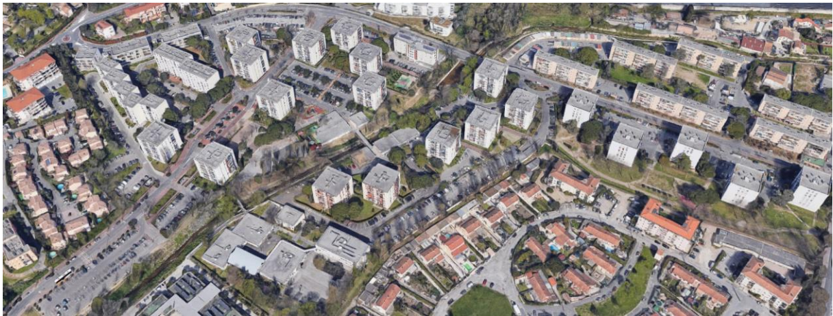
Quartier de la Frayère / Crédits : Street view
