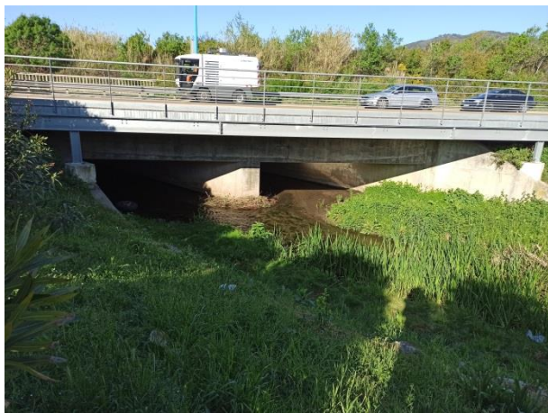
Cours d'eau à l'ouest du sous-secteur 2 à conserver / Source : EVEN Avril 2021
