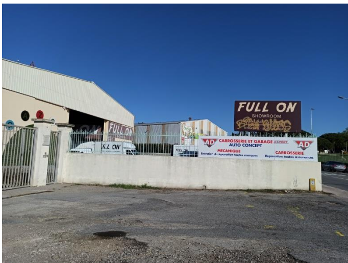
Flore spontanée qui se développe au niveau des bords de mur / Source : EVEN-Avril 2021
