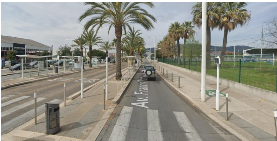
Aménagements de la voirie avenue F. Tonner
