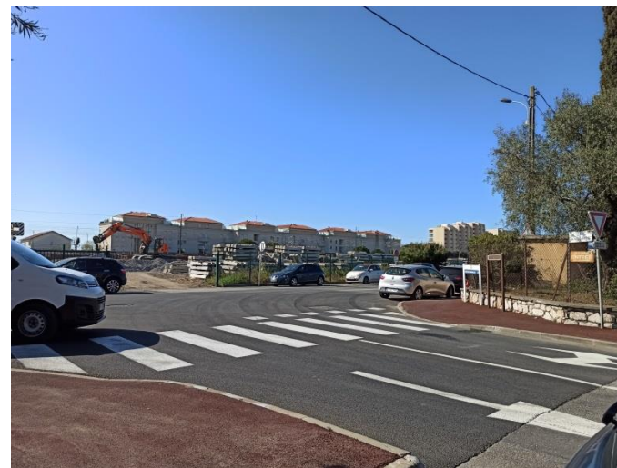
Vue sur un chantier dans le sous-secteur 2 – ZI de la Roubine / Source : EVEN Avril 2021
