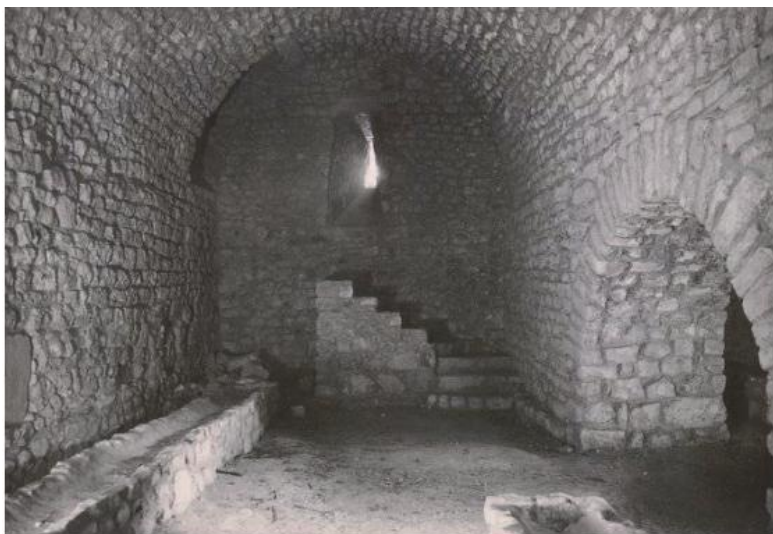
Rez-de-chaussée du bâtiment A de la tour. Archives de l'abbaye de Lérins.
