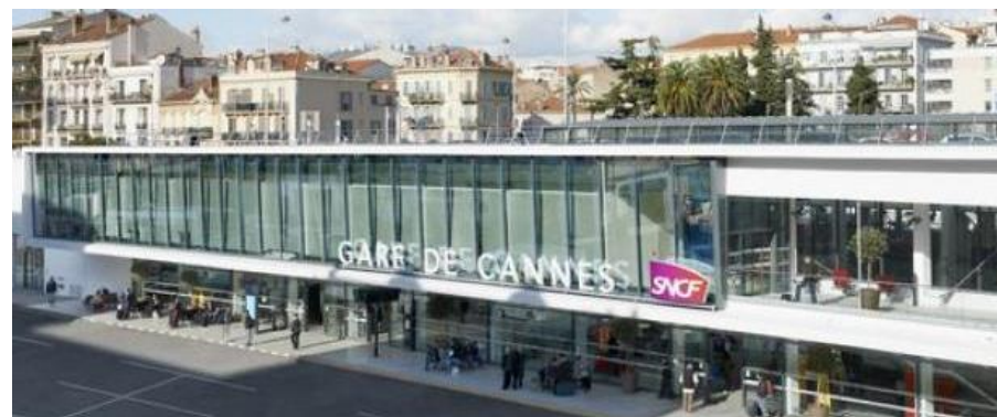
Gare de Cannes centre rénovée // crédit : Google image
