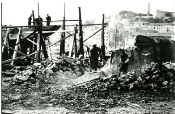
Démolition du mur construit par les Allemands sur la plage à la Libération 13Fi10
